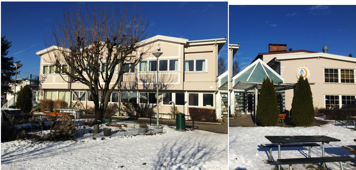
Fasade av Haraldsheim. Fra høyre: Front og hovedinngang.
