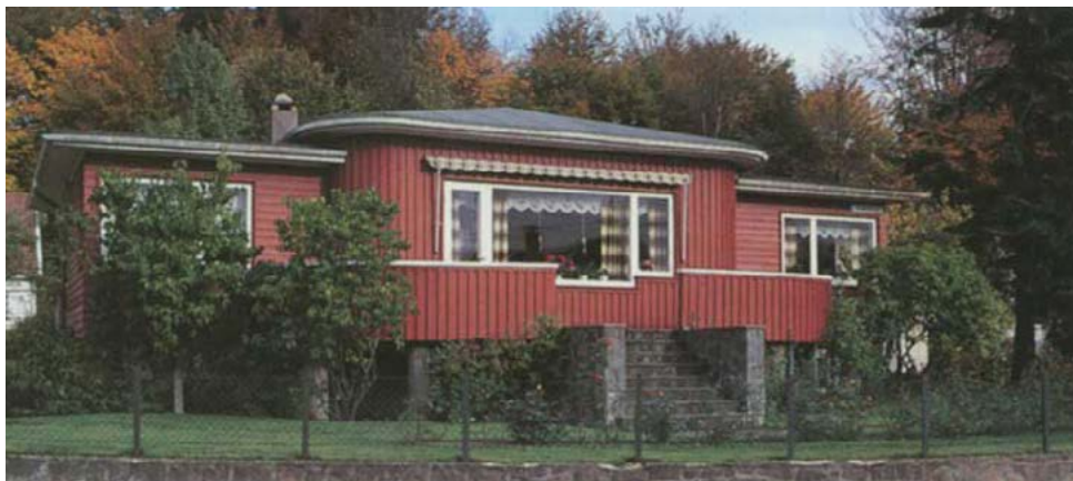
Figur 19 . Villa Drange ved Kristiansand; Sørlandsmodernisme v/ Thilo Schoder.
