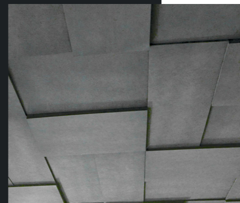
Akustikkplater i taket
