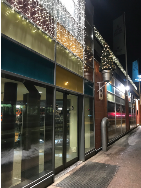
Fasade inngang B
