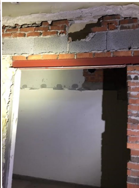
1. etg. Det er satt opp ekstra bæring på flere steder etter sprengningsarbeider.
