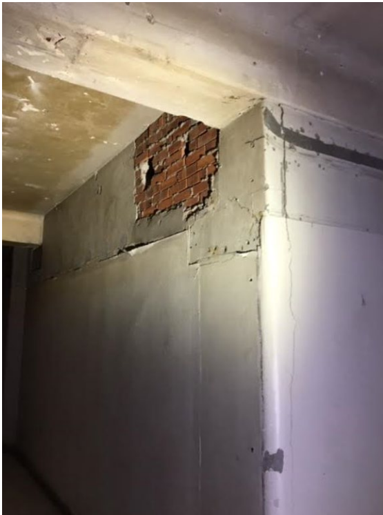
1. etg. Ytre vegger har stor slitasje og det er flere steder mulig å skimte teglvegger bak.
