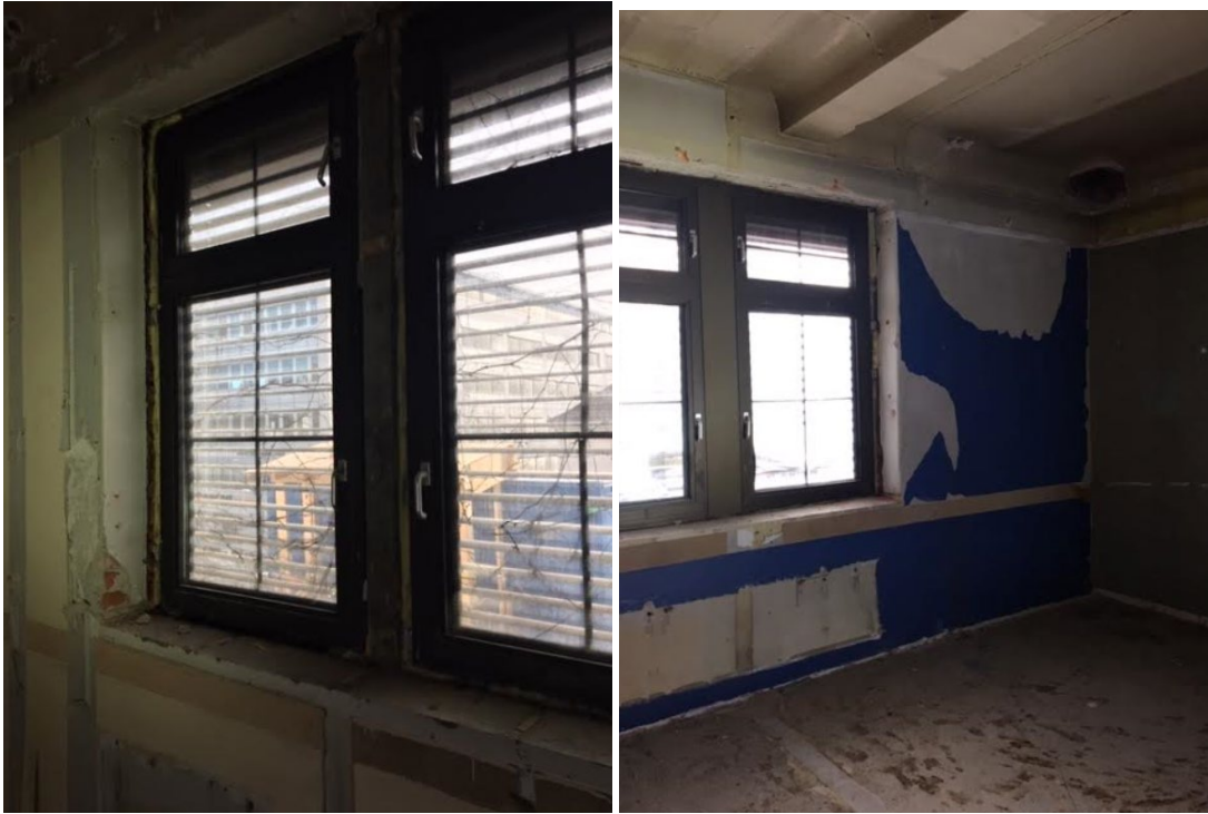
2. etg. har noen få vinduer av «nyere» tid, estimert satt inn ila de seneste 15 årene.
