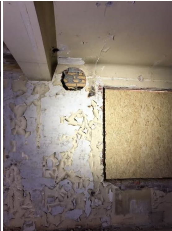
1. etg. Ytre vegger har stor slitasje og det er flere steder mulig å skimte teglvegger bak.
