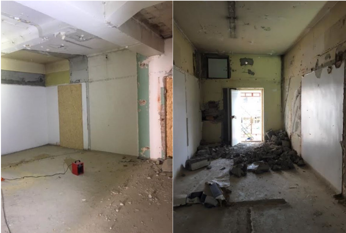
2. etg. Likt første etasje, slitt og få arkitektoniske detaljer annet enn bjelker i tak.
