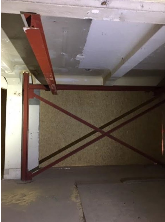
1. etg. Det er satt opp ekstra bæring på flere steder etter sprengningsarbeider.
