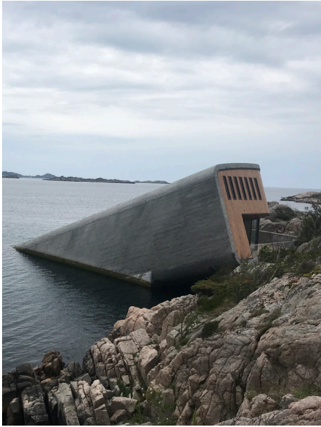
Restaurant sett utenfra.
