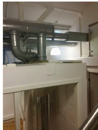
Overgang mellom cellekontorer og tak - 4 etg.
